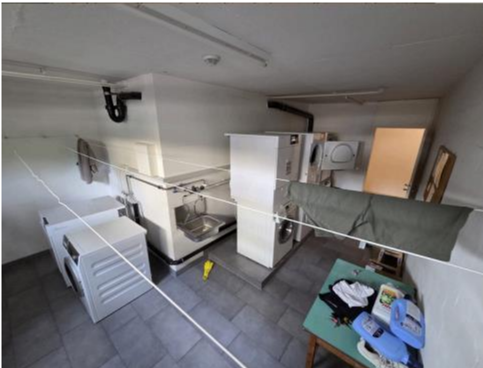
Standbild Kirchgasse 3 | Waschküche EG
