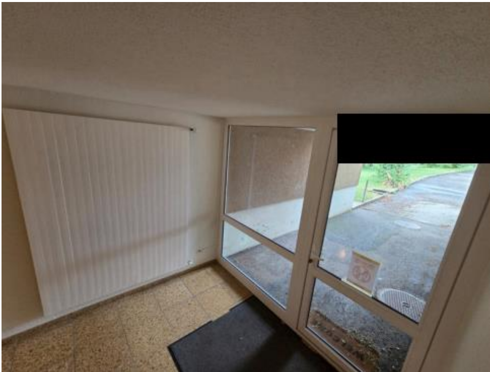
Standbild Rebhaldenstrasse 25 | Eingang rechts UG
